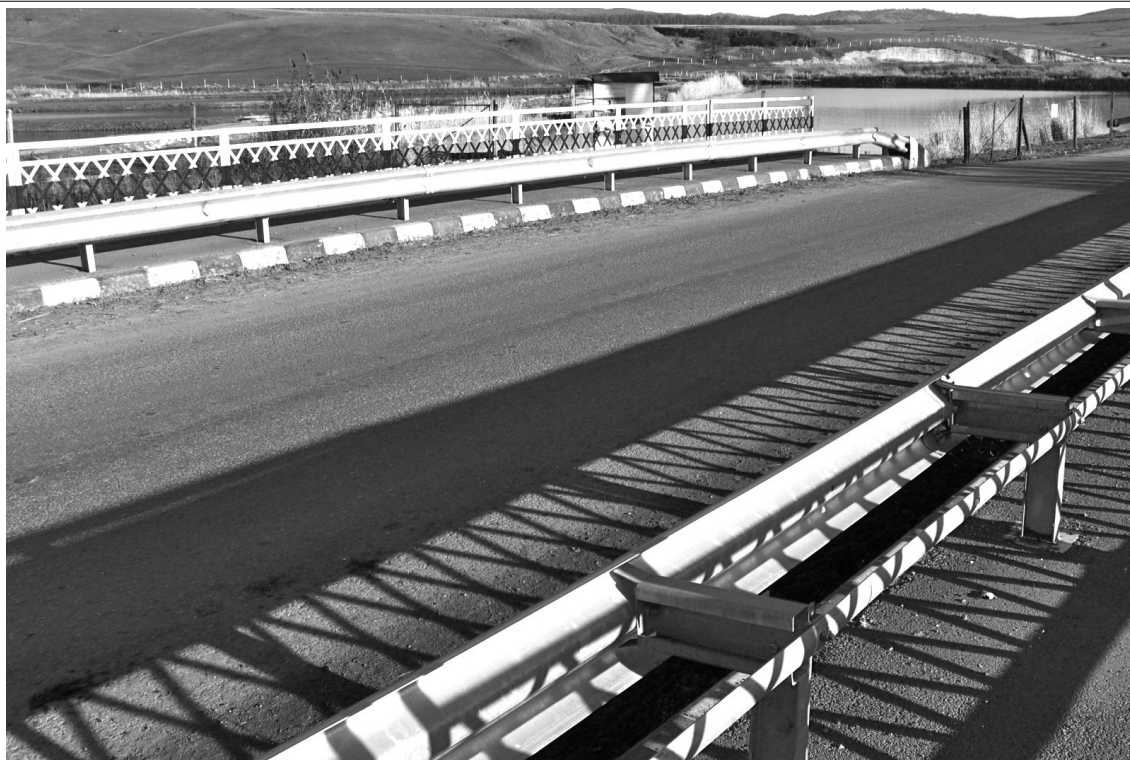
Az országút Nagy Homoródon átvezető beton szerkezetű fém mellvédes hídja.
