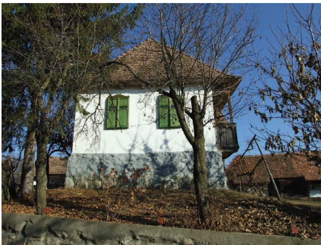
- case din bârne de lemn, pe elevație din piatră cu prispă laterală din lemn
