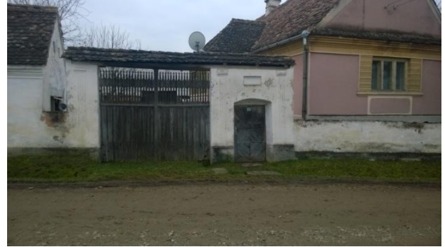
Fénykép utca felőli nézet / foto: vedere dinspre stradă
