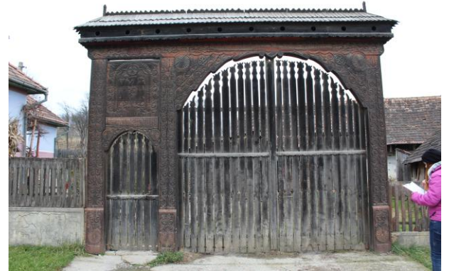
Fénykép utca felőli nézet / foto: vedere dinspre stradă
