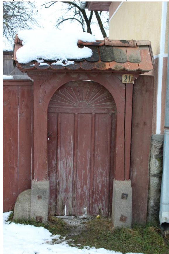
Fénykép utca felőli nézet / foto: vedere dinspre stradă
