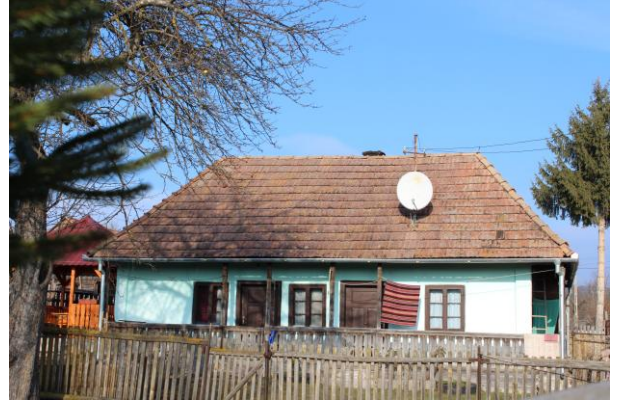
Fénykép utca felőli nézet / foto: vedere dinspre stradă
