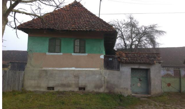
Fénykép utca felőli nézet / foto: vedere dinspre stradă
