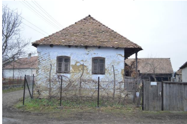
Fénykép utca felőli nézet / foto: vedere dinspre stradă
